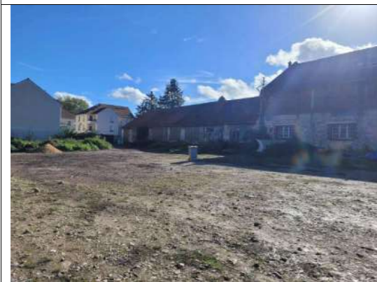
Vue du grand bâtiment au sud
