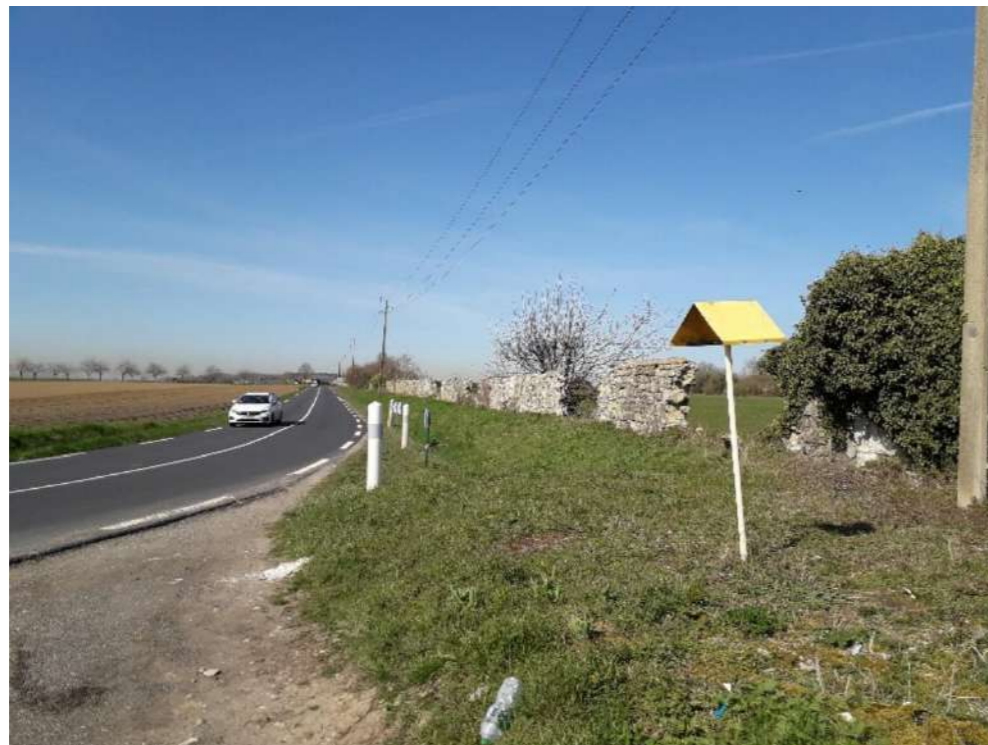
Figure 122 : Canalisation de gaz localisée au Sud du site d'étude
