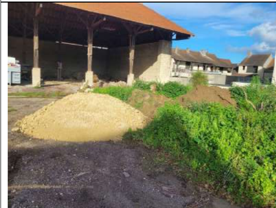
Vue des tas à proximité de l'auvent (à l'Est)
