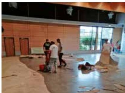
Après un démontage complet des gradins, un travail de décollement du revêtement initial s'est enclenchée, suivi par le ponçage du sol en ciment pour une préparation uniforme du sol en décaissant sur 3mm. S'en est suivi ensuite la première passe d'un produit primaire pour l'accroche, puis une fois sec, la couche de résine choisie d'une couleur adaptée à la salle de spectacle fut posée.
