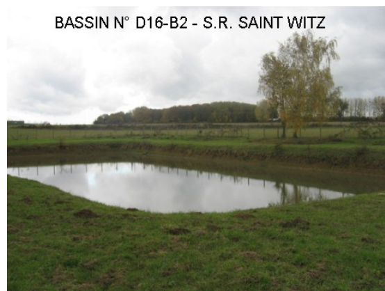
Photographie du bassin d'infiltration routier D16-B2 de Saint-Witz
