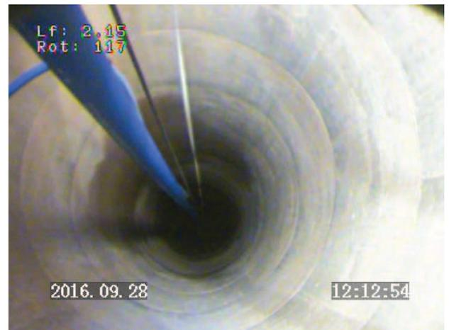
**Bon état du cuvelage béton entre 0 et 11,05m.**
