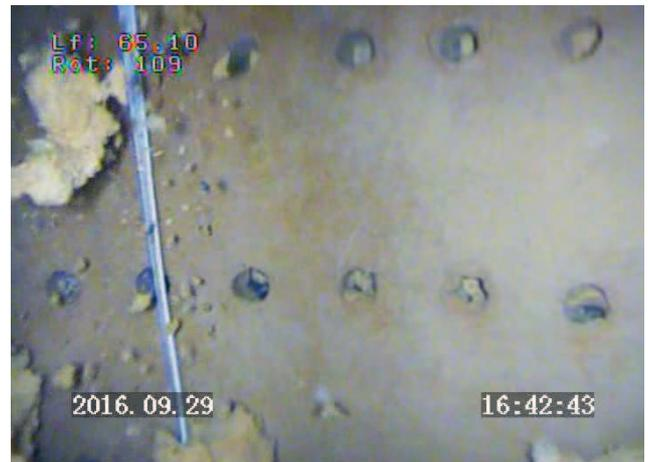
**Dépôts non indurés sur 0,2m à la base du puits. Remblais sur une épaisseur estimée à 1,4m.**
