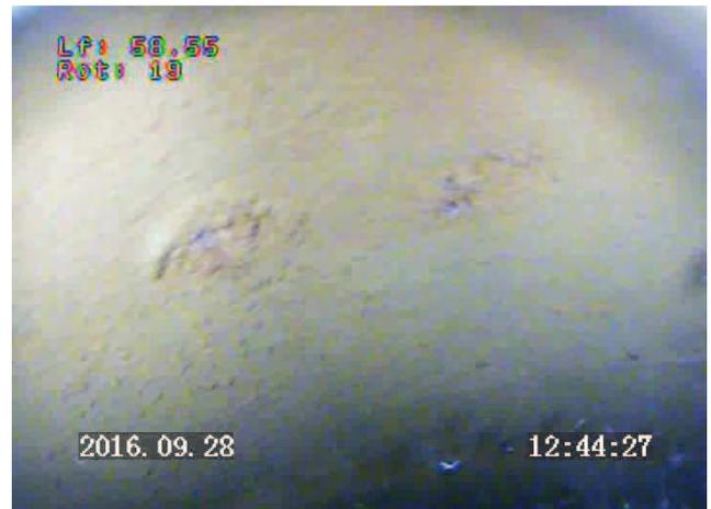
**Filtres Cuau fortement colmatés par des dépôts d'oxydes entre 58,5m et 59m.**
