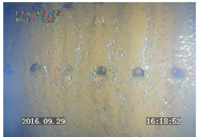
**Petits écoulements d'eau sur un côté du forage.**
