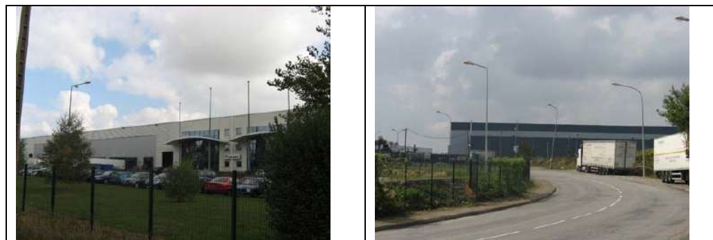
Figure 36 : Photos du bâti en zones d'activités
