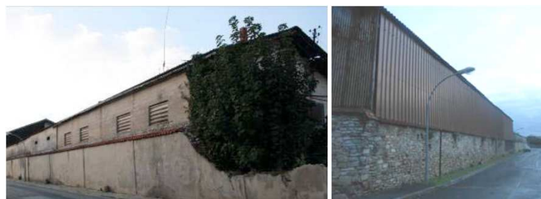
Façades sur la rue Delanchy (avant démolitions récentes)
