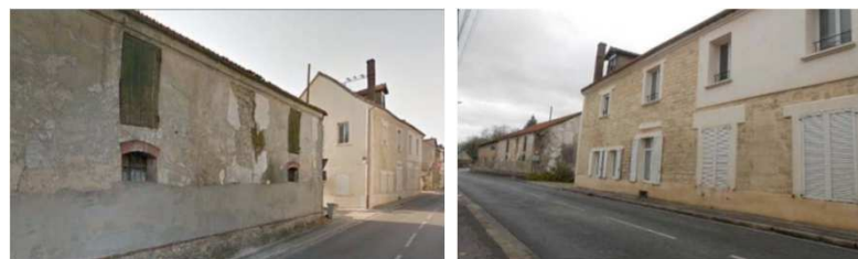
Façades sur la rue Gabriel Péri
